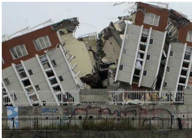
Cile: un'immagine emblematica dei danni che può provocare un sisma della potenza di quello del 27 febbraio.
